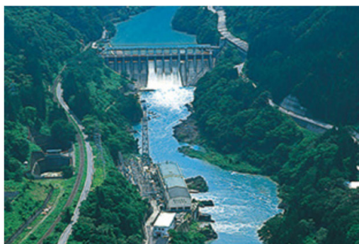
宮下発電所（東北電力）
