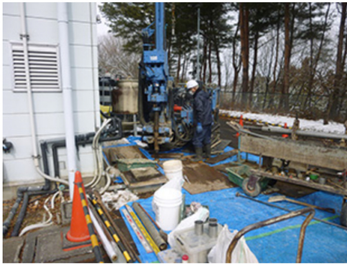
土壤ガス吸引井戸設置工事
