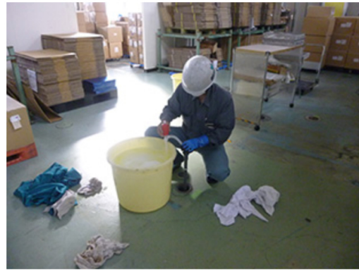
土壤浄化薬剤注入
